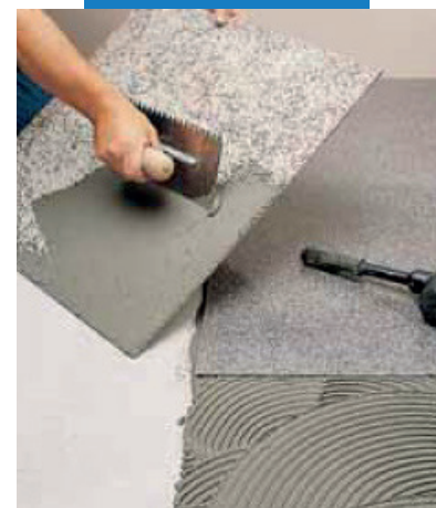
Укладка гранита с помощью серого Granirapid (Гранирапид)
