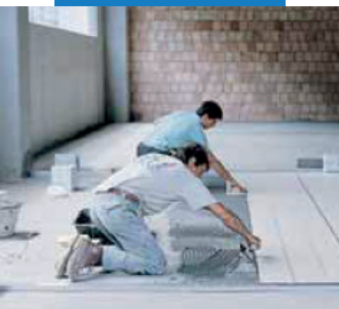
Укладка керамогранита в промышленных помещениях
